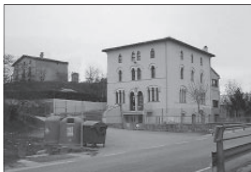
Edifici actual de Les Escoles
